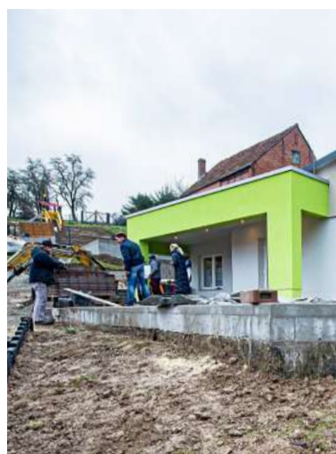
Auch die Außenanlagen rund um den Kindergarten Rasenzwerge nehmen Form an.
